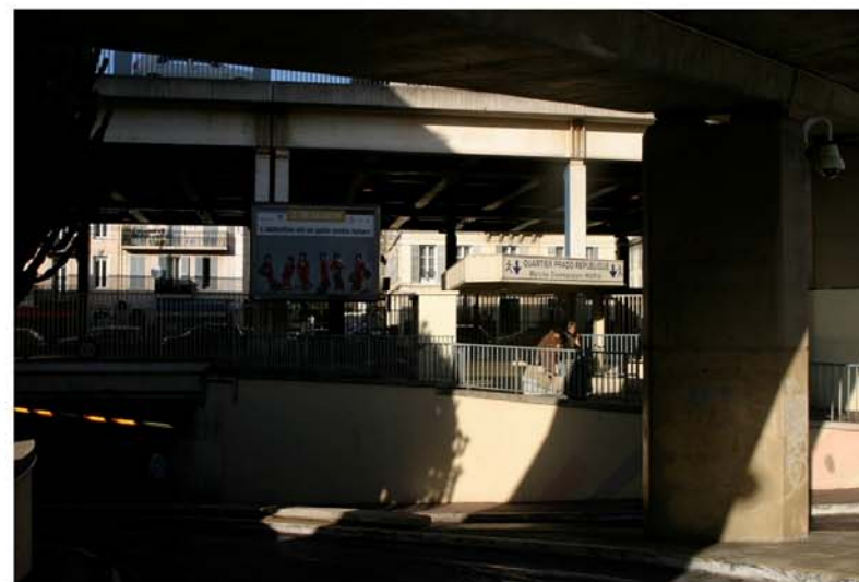
Traversée piétonne souterraine et viaducs routiers au droit de la pl. Gambetta et du p. Châteaudun
