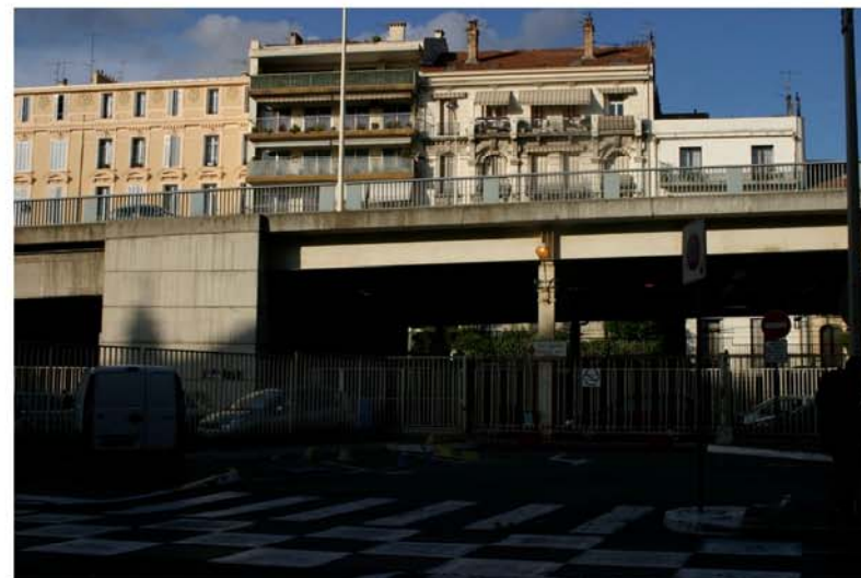
la voie ferrée à hauteur du sol, elle interdit le passage entre le quartier Saint-Nicolas et le centre.
