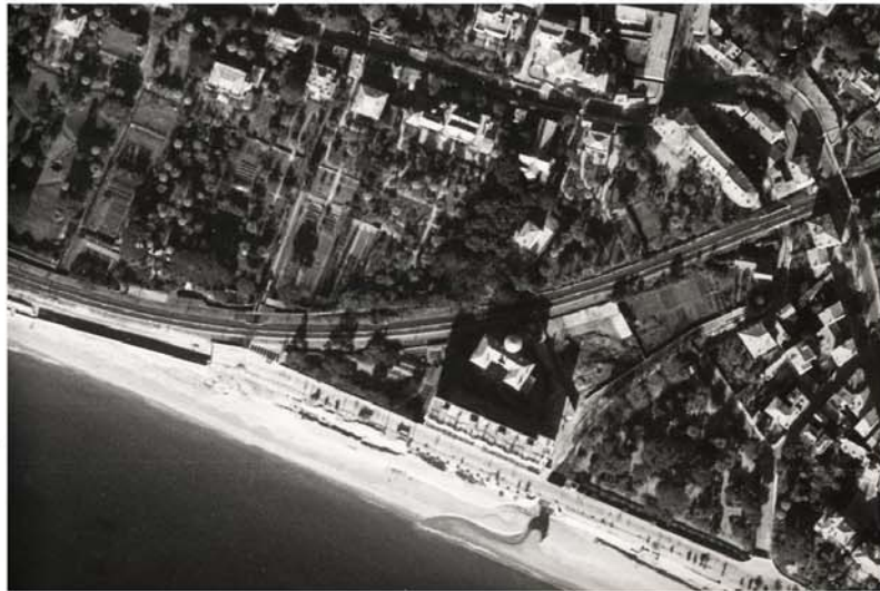
Chantier de soutènement du boulevard du Midi, interrompu par la guerre de 1940.
